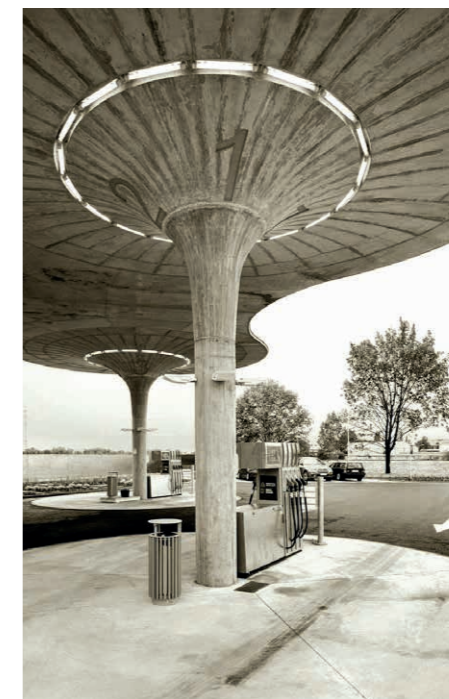
Čerpací stanice GAS Matúškovce, Atelier SAD 2011
